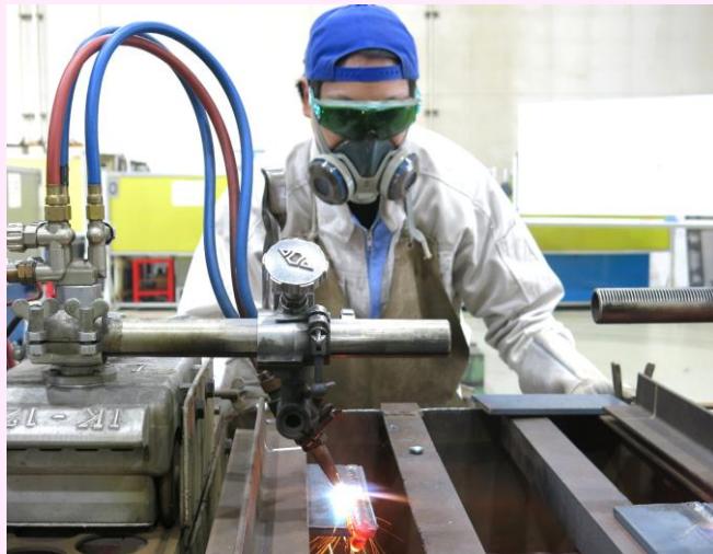
自動ガス切断
